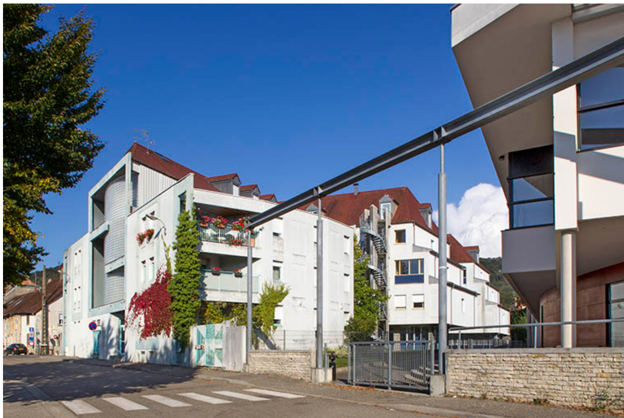
Internat : entrée, rue de Versailles.
