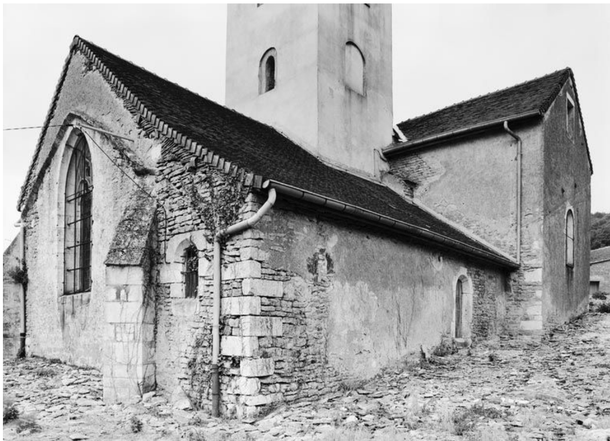
Elévation gauche du choeur et chapelle gauche.
