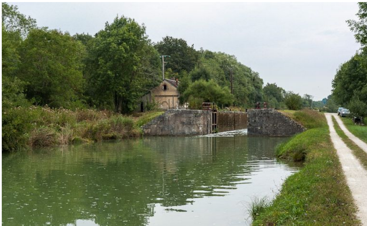
Le site d'écluse vu d'aval.
