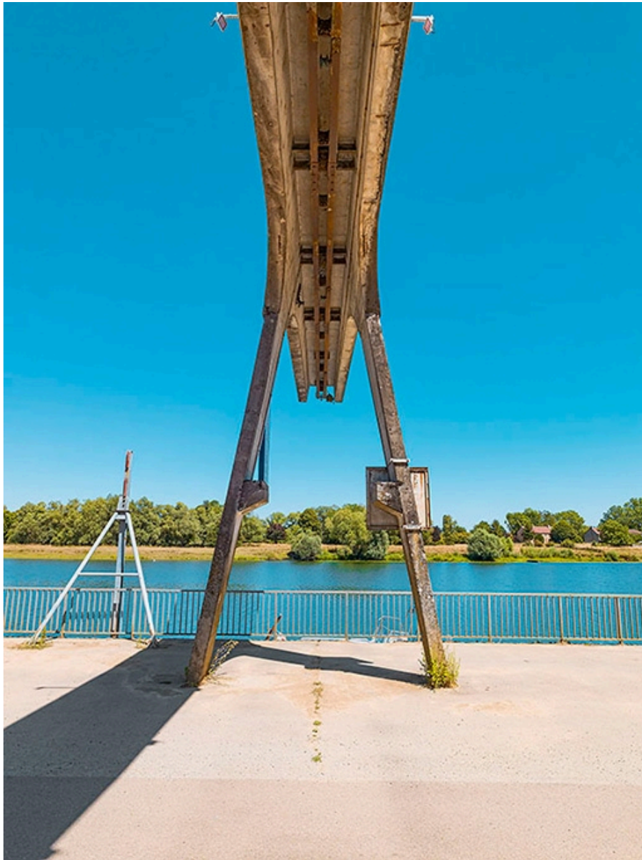
Portique de déchargement avec poulie.
