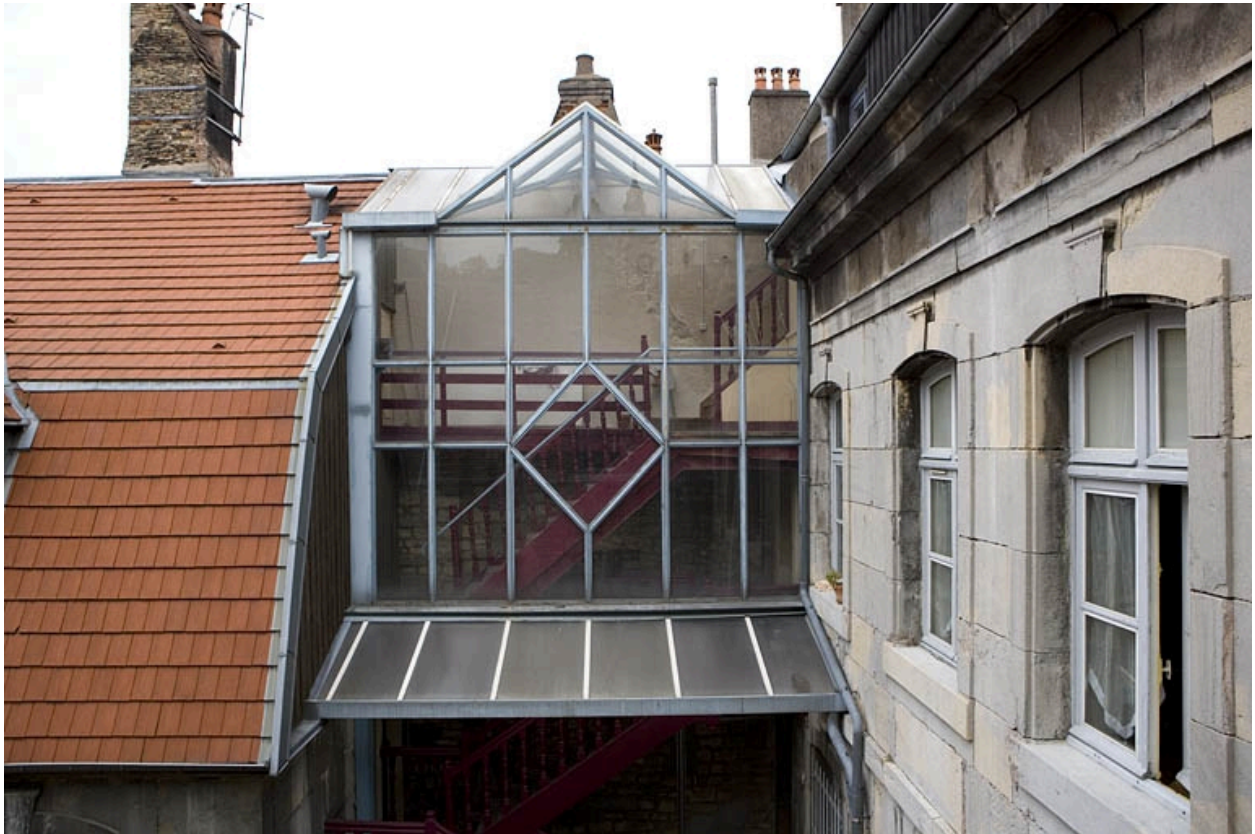
Détail de la verrière au-dessus de l'escalier à cage ouverte.
