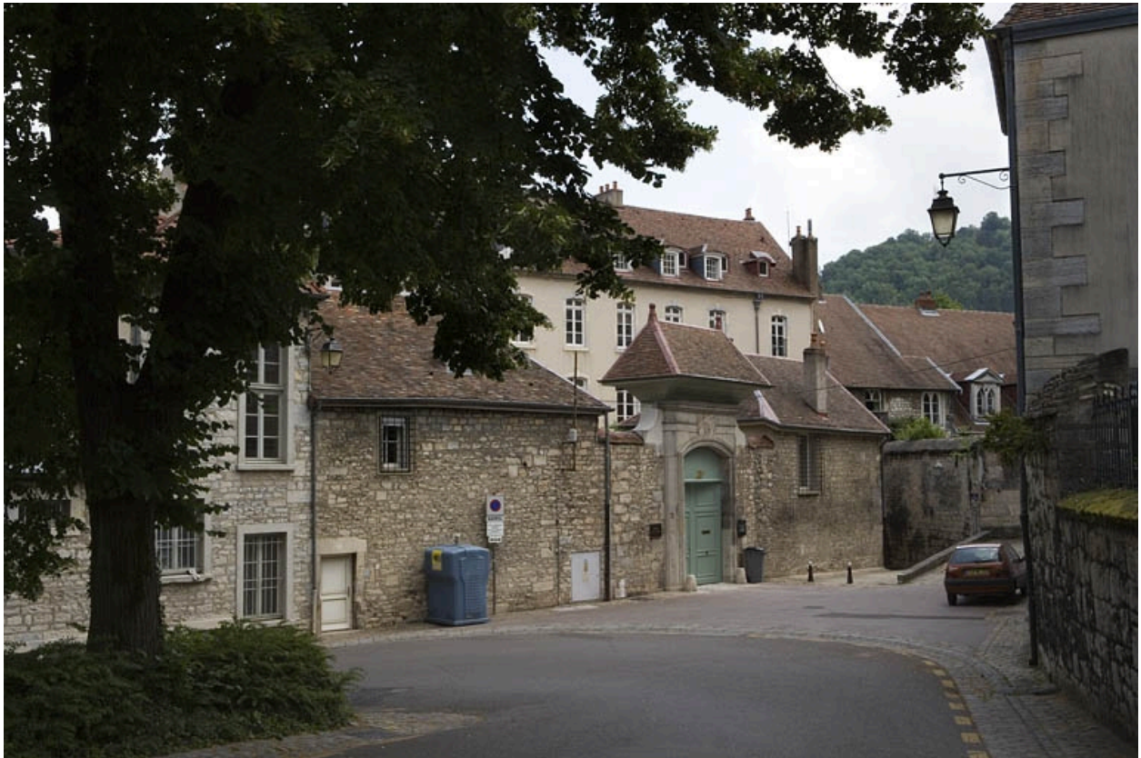
Vue d'ensemble du portail d'entrée depuis l'extérieur.
