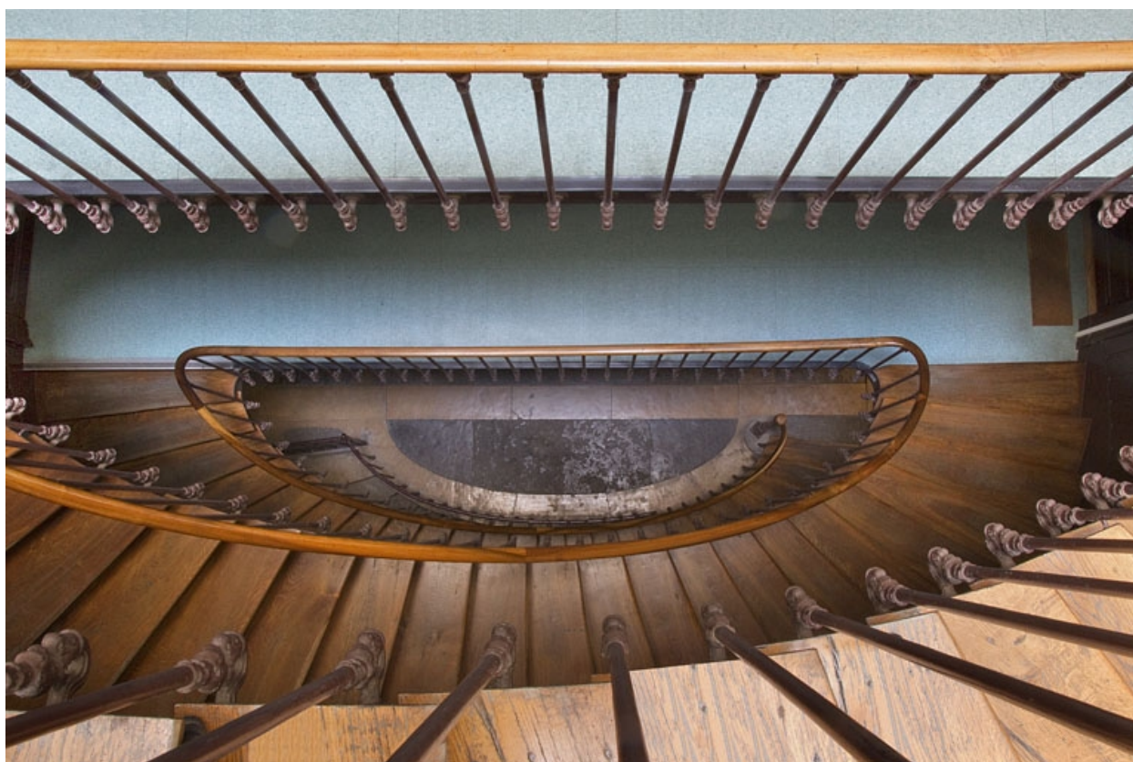
Intérieur, escalier : vue plongeante.
