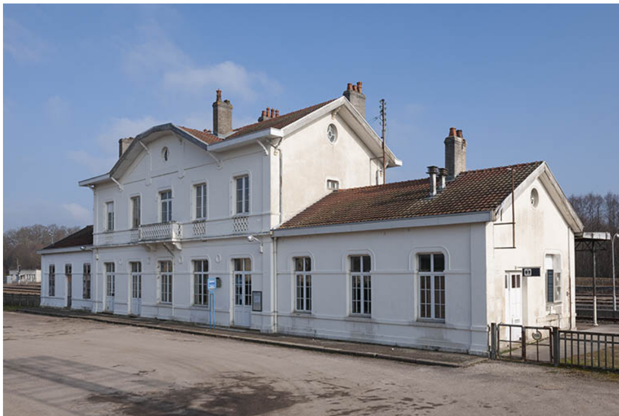
Port-d'Atelier : vue générale de la gare.
