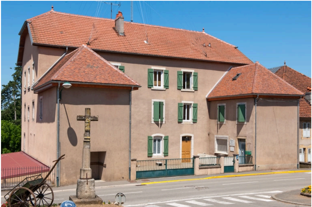
Vue générale rapprochée de trois quart gauche.
