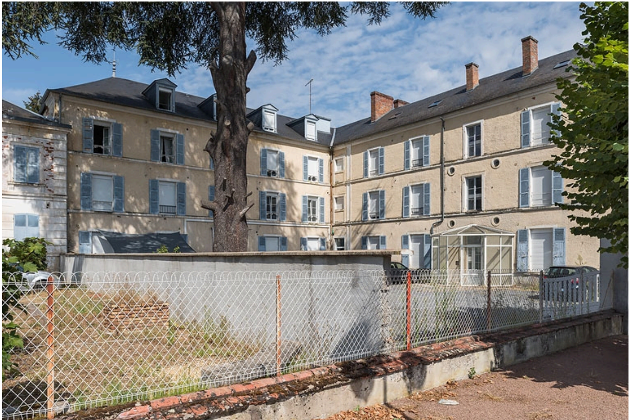
Façade sud du corps principal et façade est de l'aile en retour, vue en 2020.
