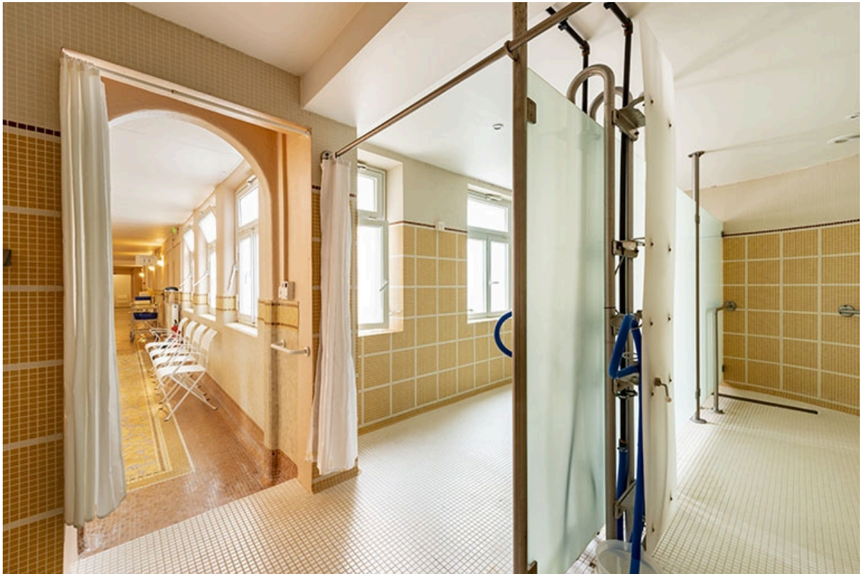
Bâtiment d'Hygie, salle de la douche à jet au premier étage, vue en direction du couloir (nord).
