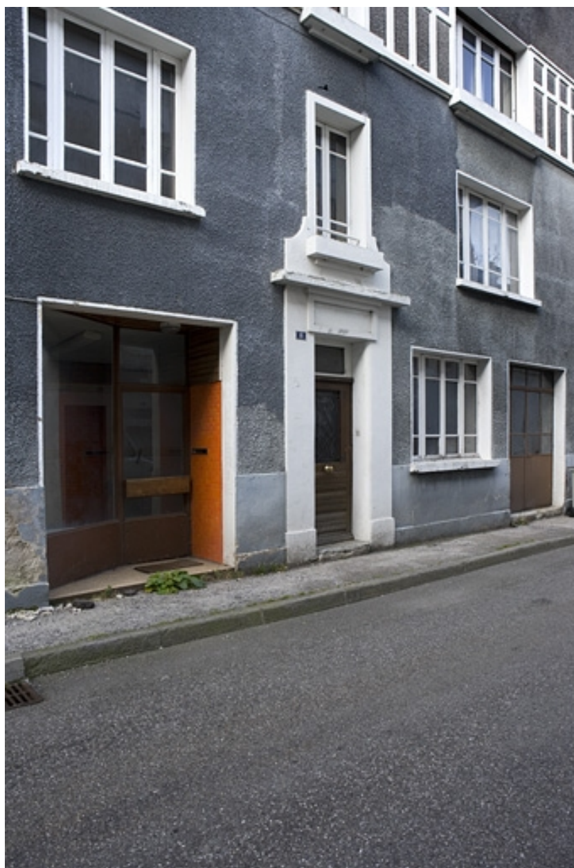
Baies du rez-de-chaussée et du premier étage.
