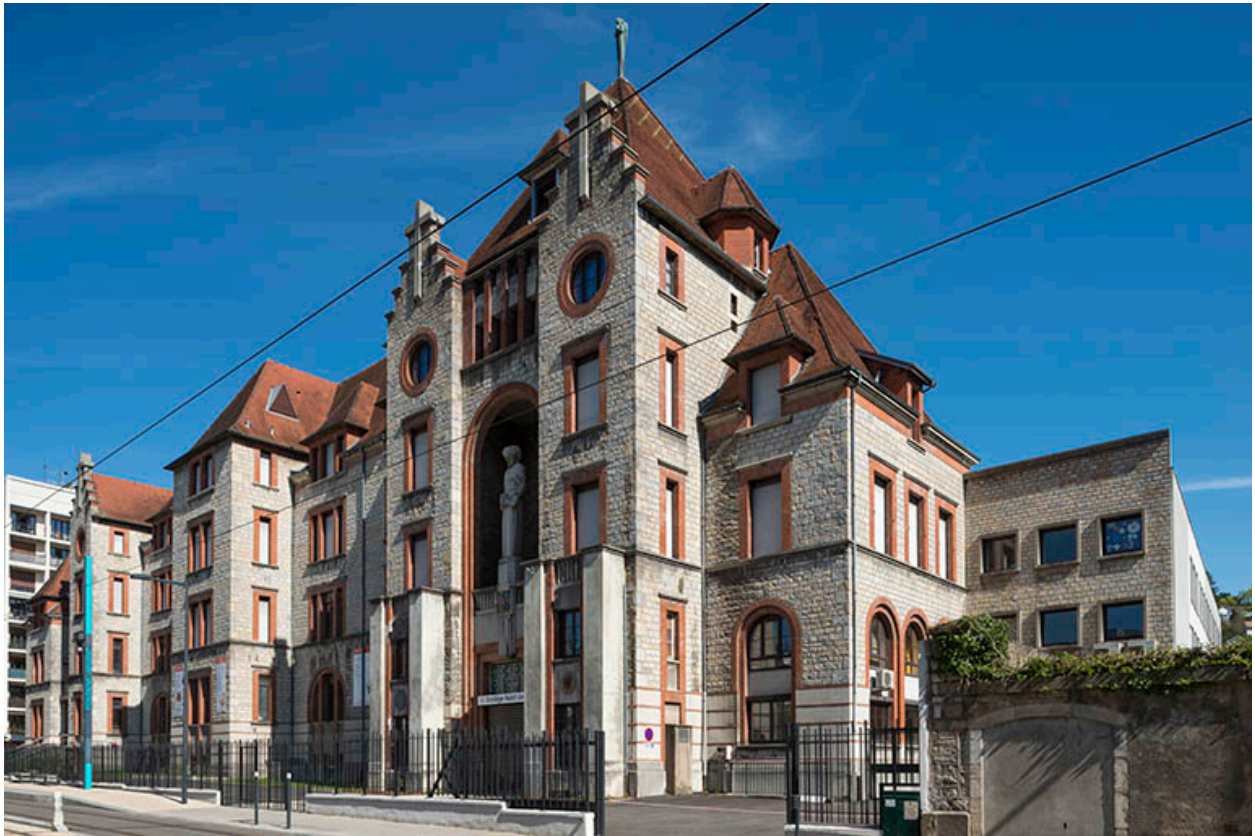
Façade antérieure du lycée. Vue de trois quarts droite.
