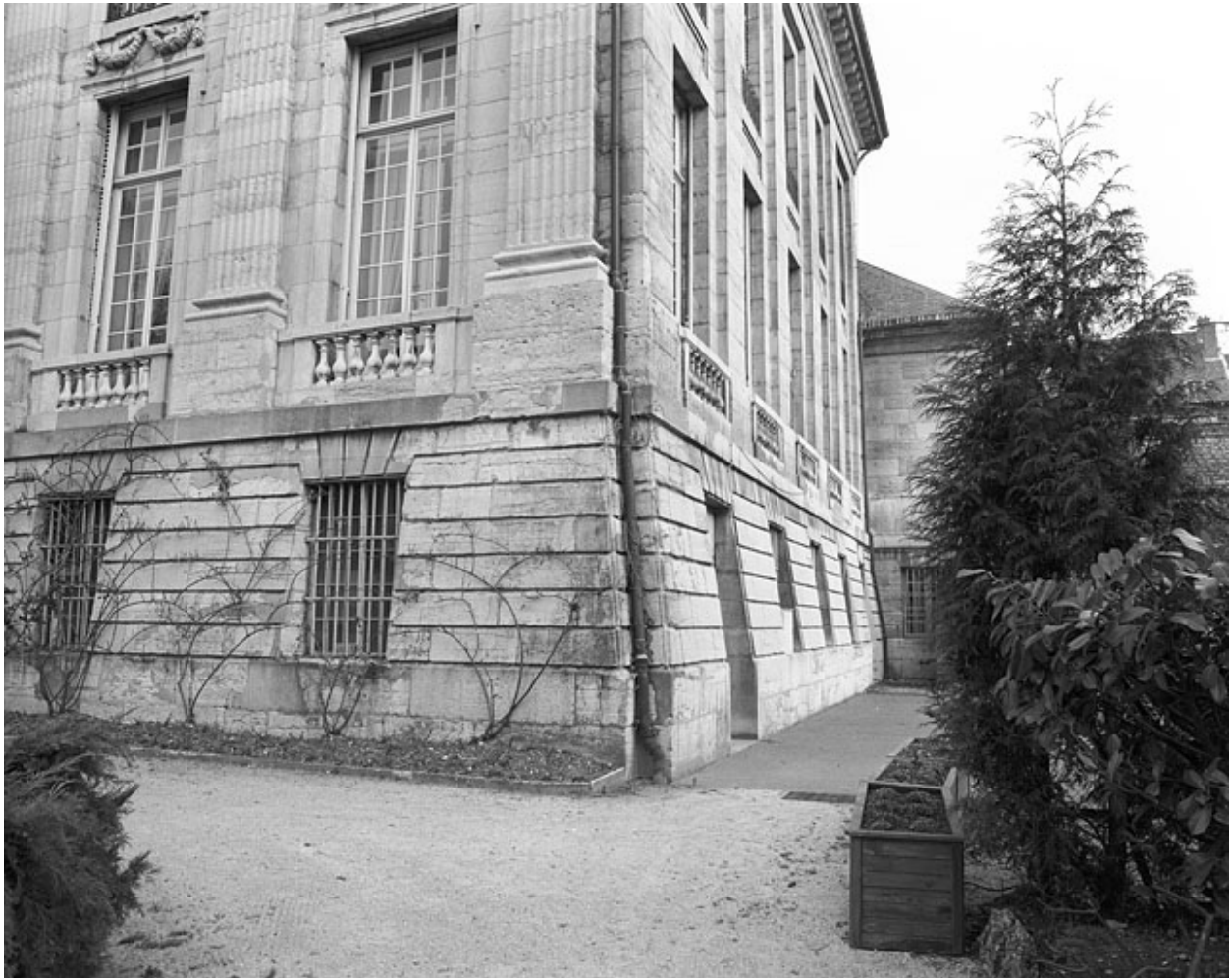
Façade postérieure : détail du soubassement de l'angle droit.
