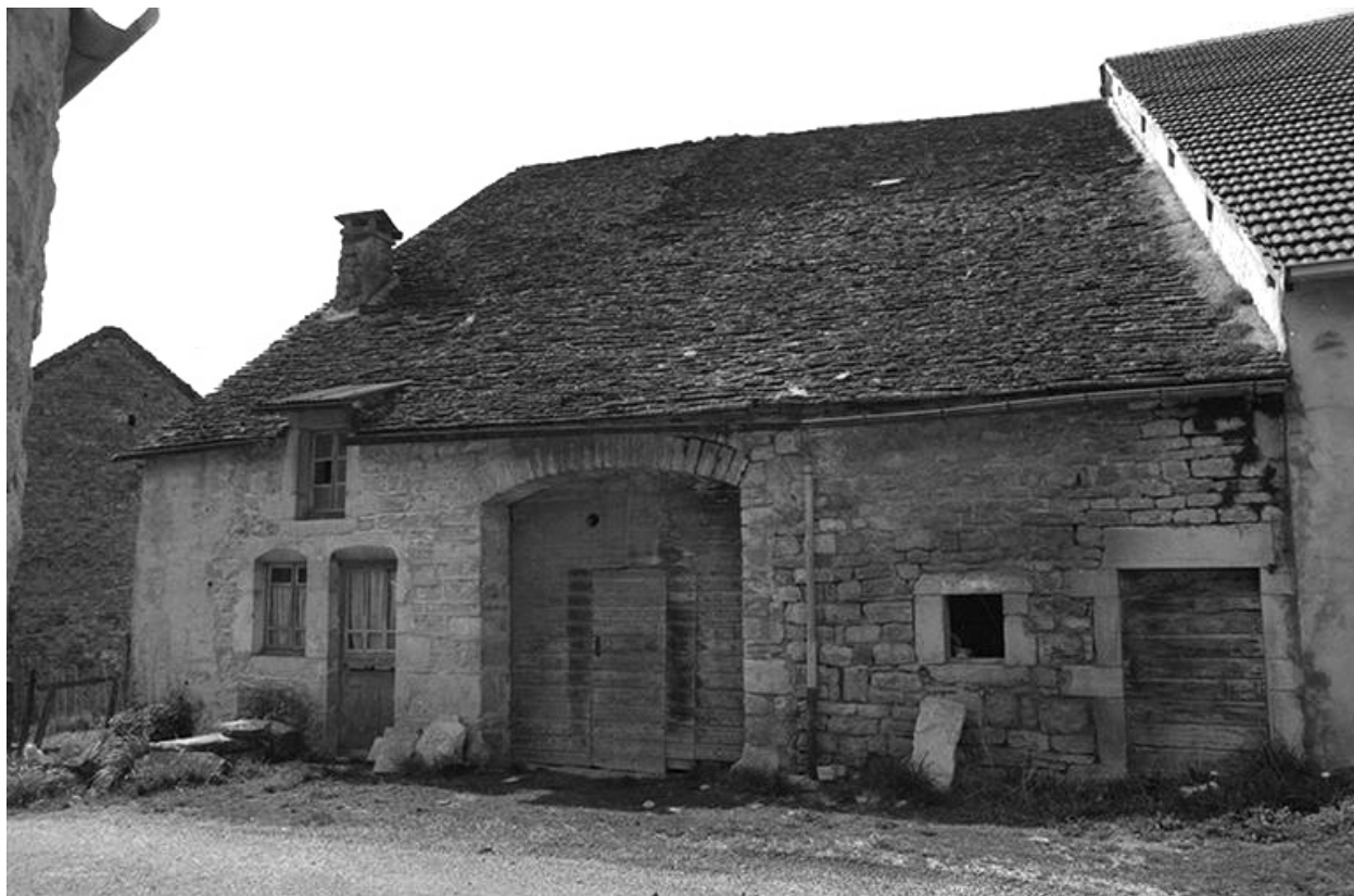
Ferme cadastrée 1964 AB 86 : façade est.
