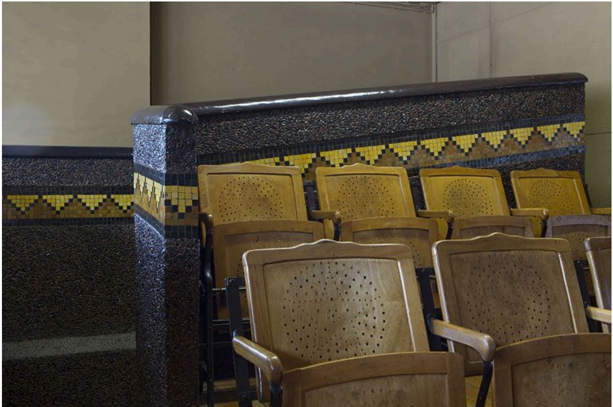
Bâtiment B, grand amphithéâtre : muret avec revêtement de gravillons et mosaïques.
