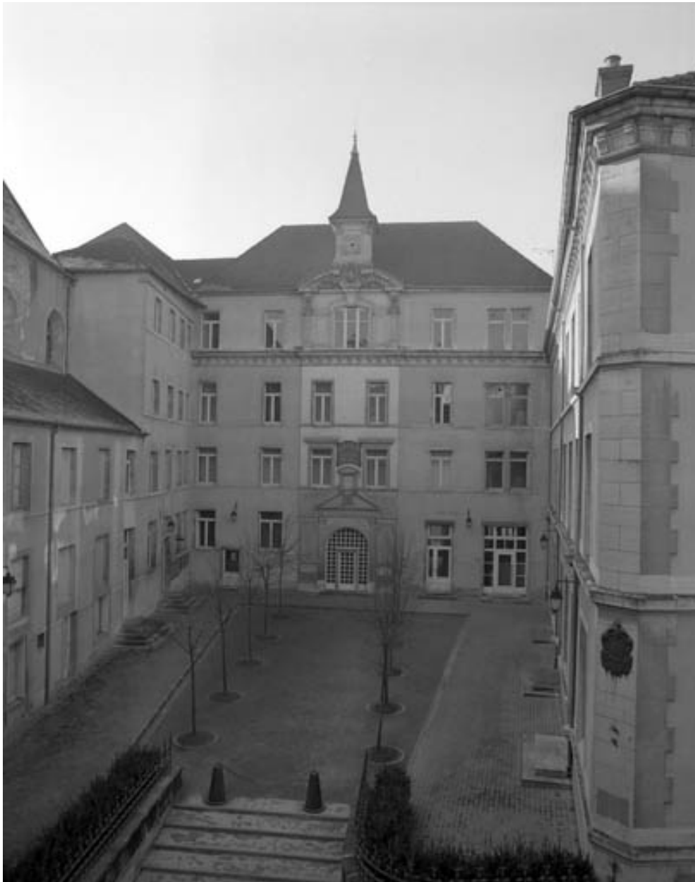
Façade antérieure du bâtiment principal en 1989.
