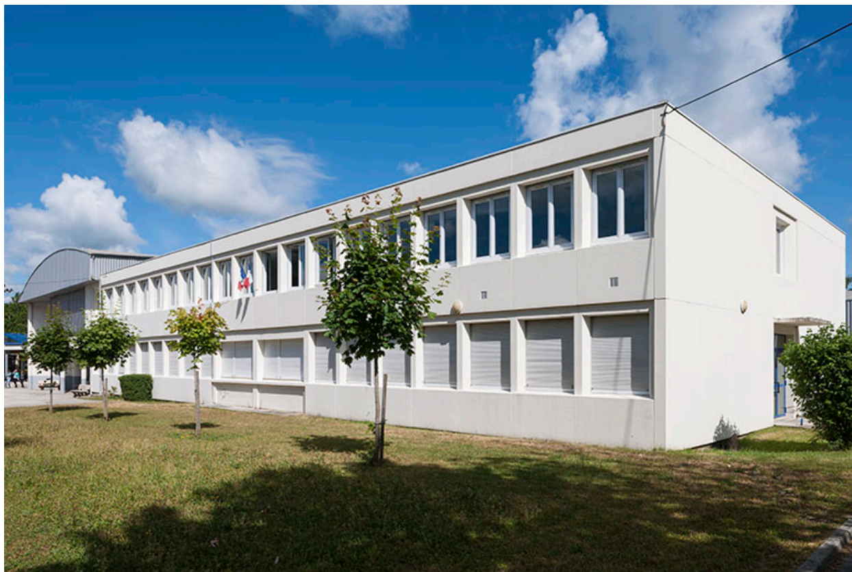
Ateliers, façade latérale Sud.
