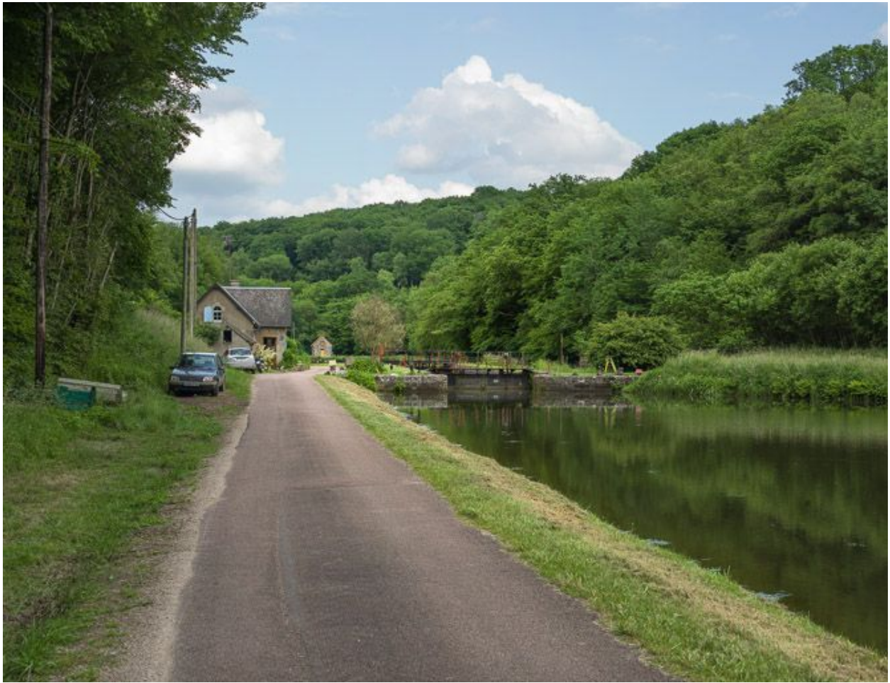
Le site d'écluse vu d'amont.
