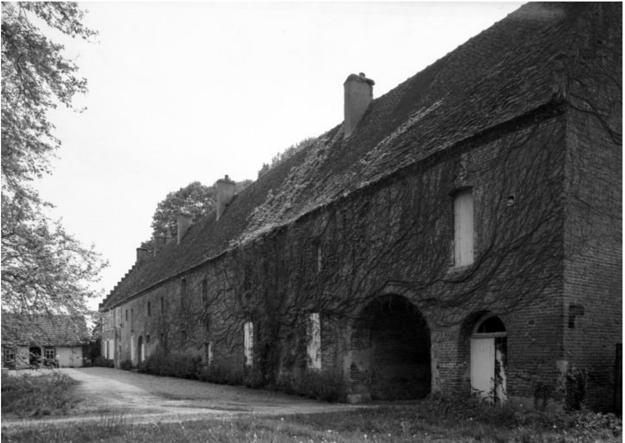
Bâtiment de l'ancien château, élévation sur cour vue de trois-quarts droit.
