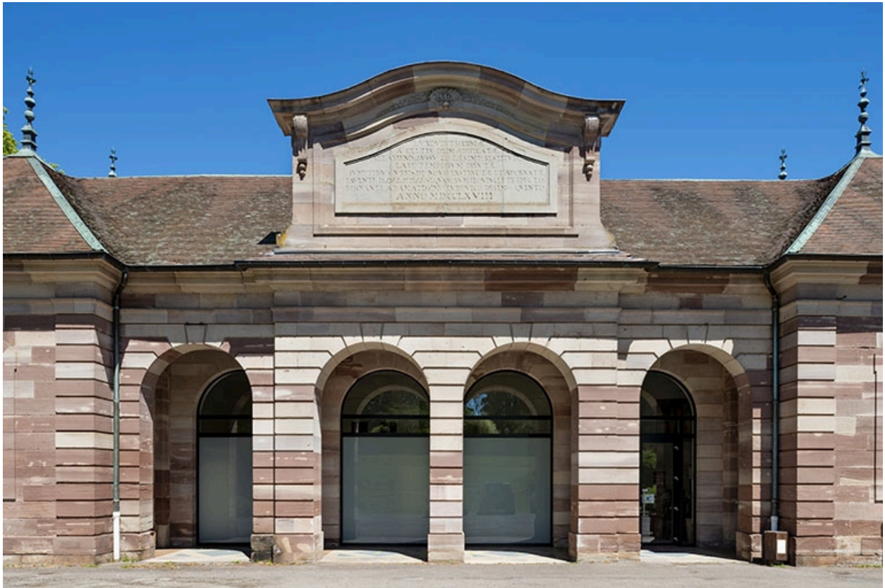
Bâtiment sud dit du Bain des Dames et du Bain des Bénédictins, galerie de la façade sud.
