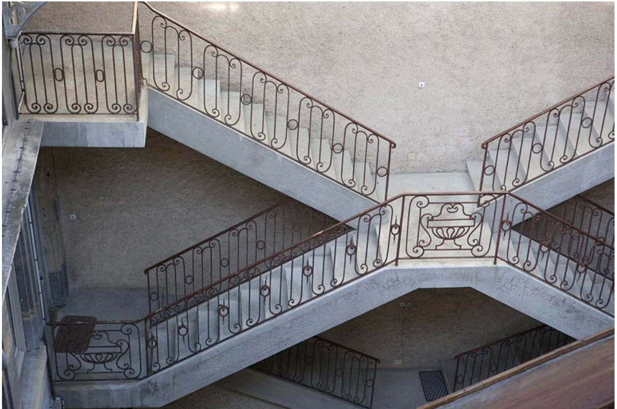
Détail de la rampe en fer forgé de l'escalier à cage ouverte, depuis la parcelle voisine.
