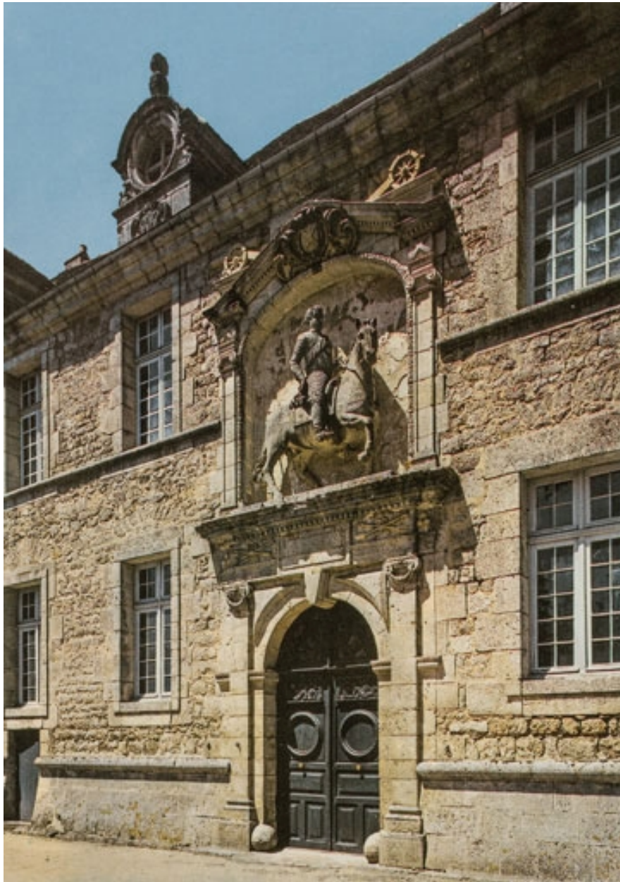
Façade sud-est, travée centrale, avant restauration.
