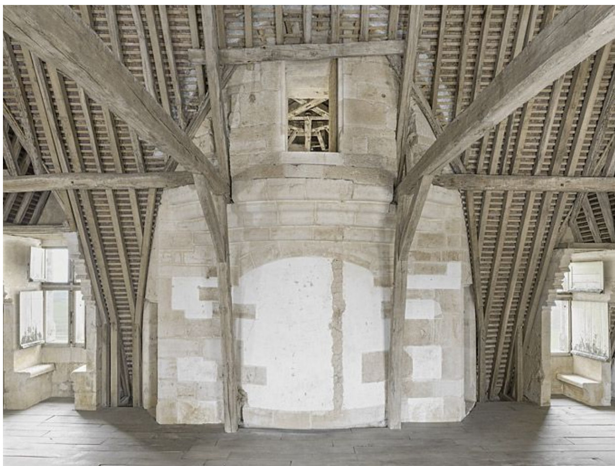
Combles : au-dessus du grand logis. Tour sud-ouest vue du comble.
