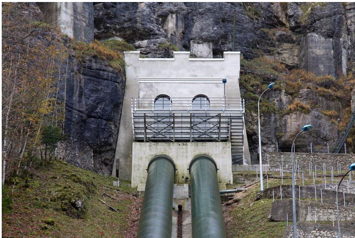
Conduite forcée : chambre de mise en charge.
