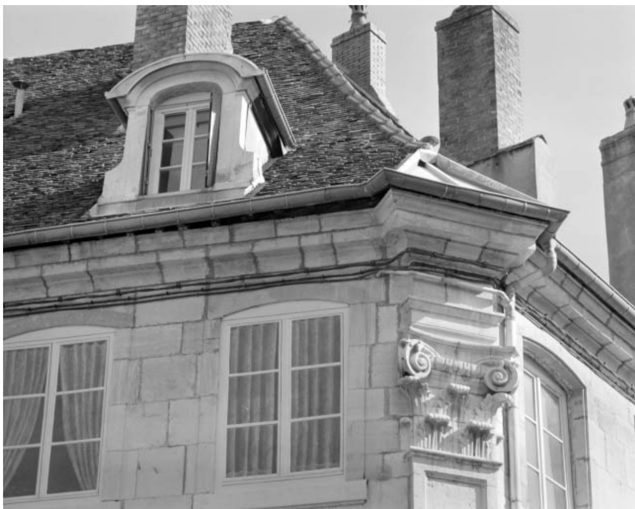
Détail du chapiteau du pilastre d'angle.
