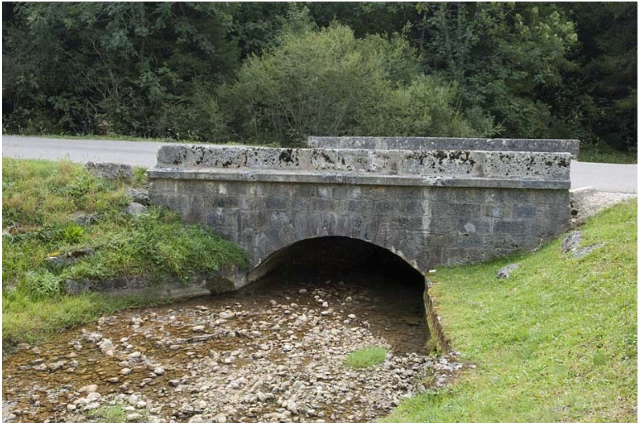
Pont sur la Jougne (n° 4), vu depuis l'amont.
