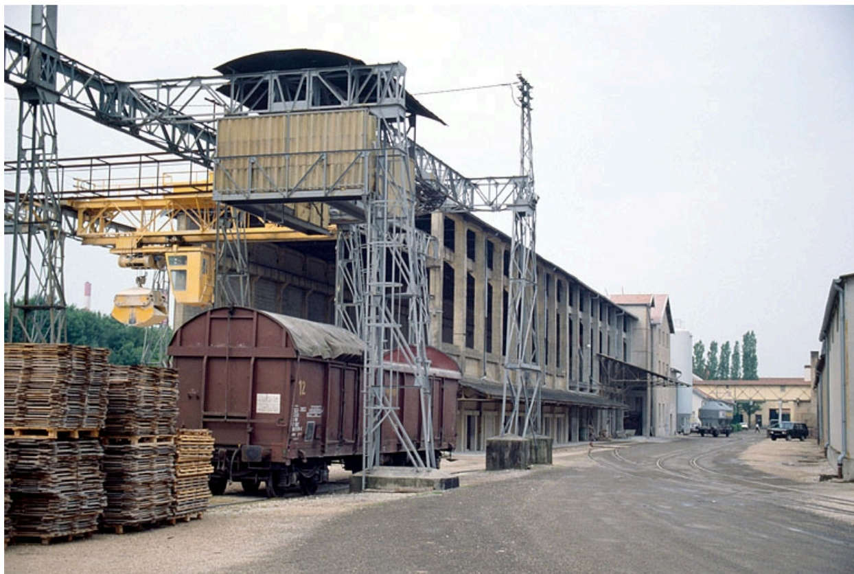
Pont roulant et hangar à terre (18).
