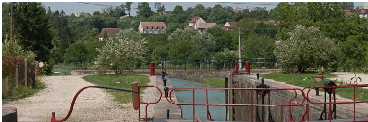
Vue du pont depuis l'amont.
