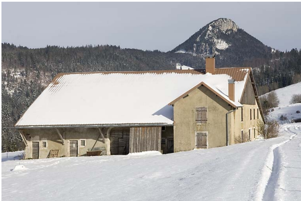
Façades antérieure et latérale droite, en hiver.
