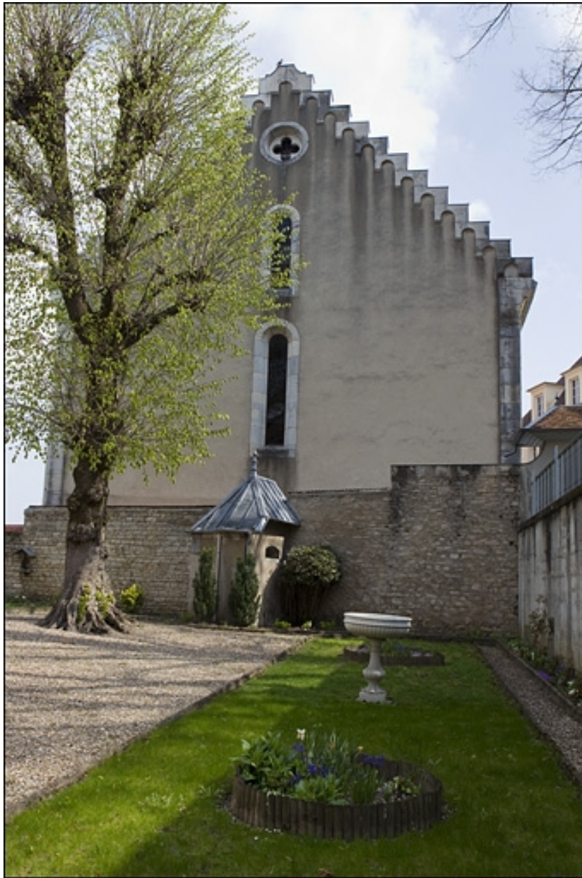
Vue éloignée du pavillon de jardin.
