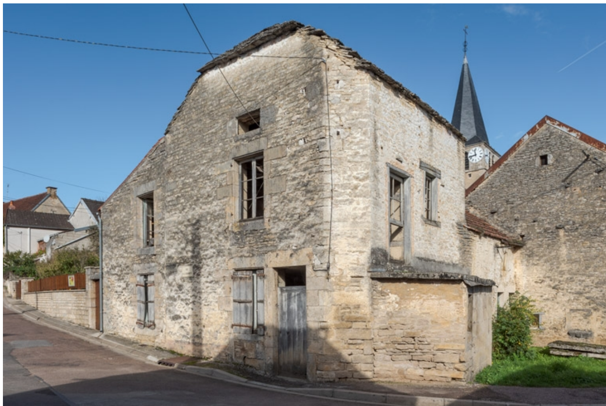
Vue d'ensemble depuis l'angle sud-est.
