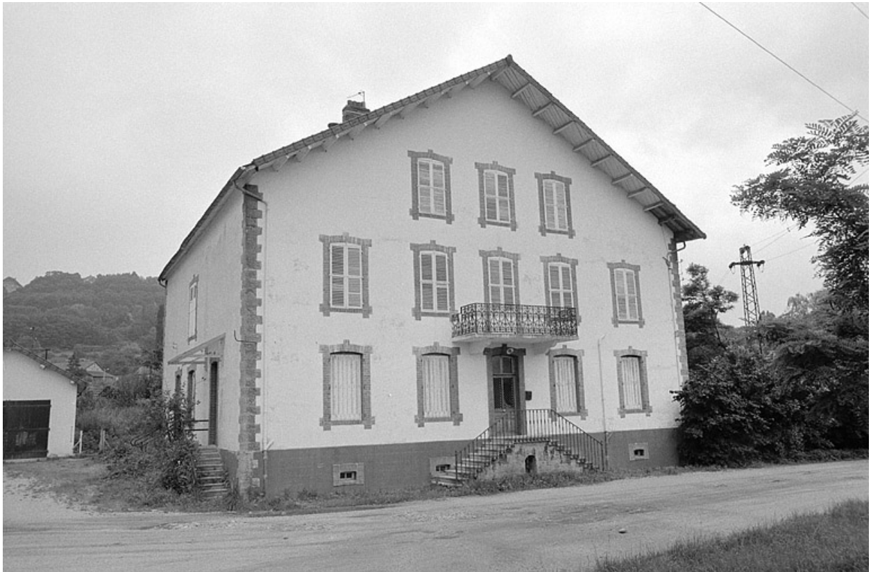
Façade antérieure du logement patronal et bureau.
