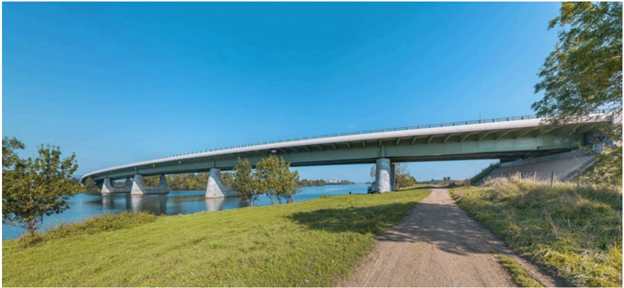
Le pont de l'A406 vu d'aval, depuis la rive gauche.
