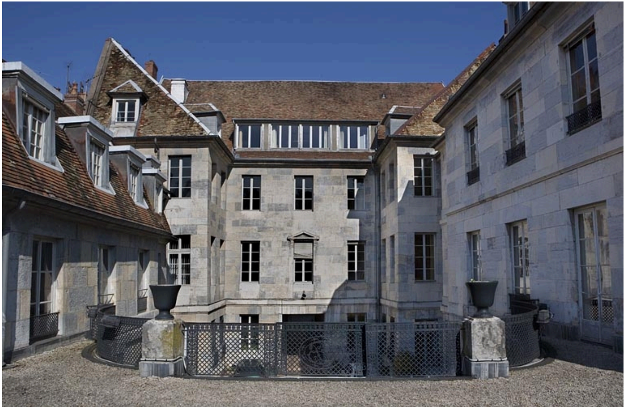
Vue d'ensemble des façades sur cour depuis la terrasse du jardin d'hiver.
