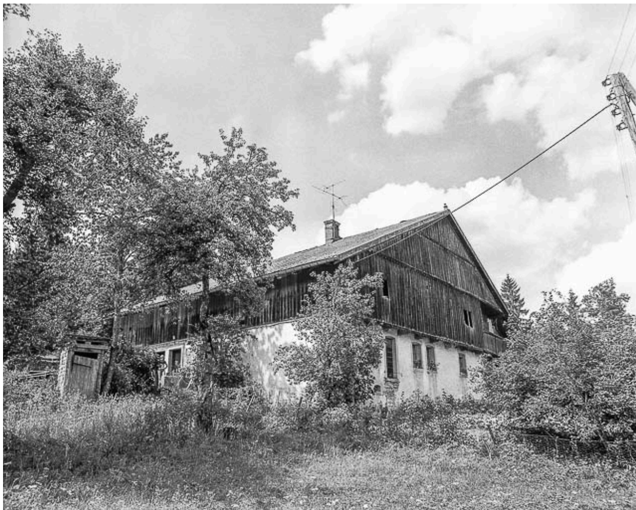
ferme située au lieu-dit Chez Prenel : Façades antérieure et latérale gauche.
