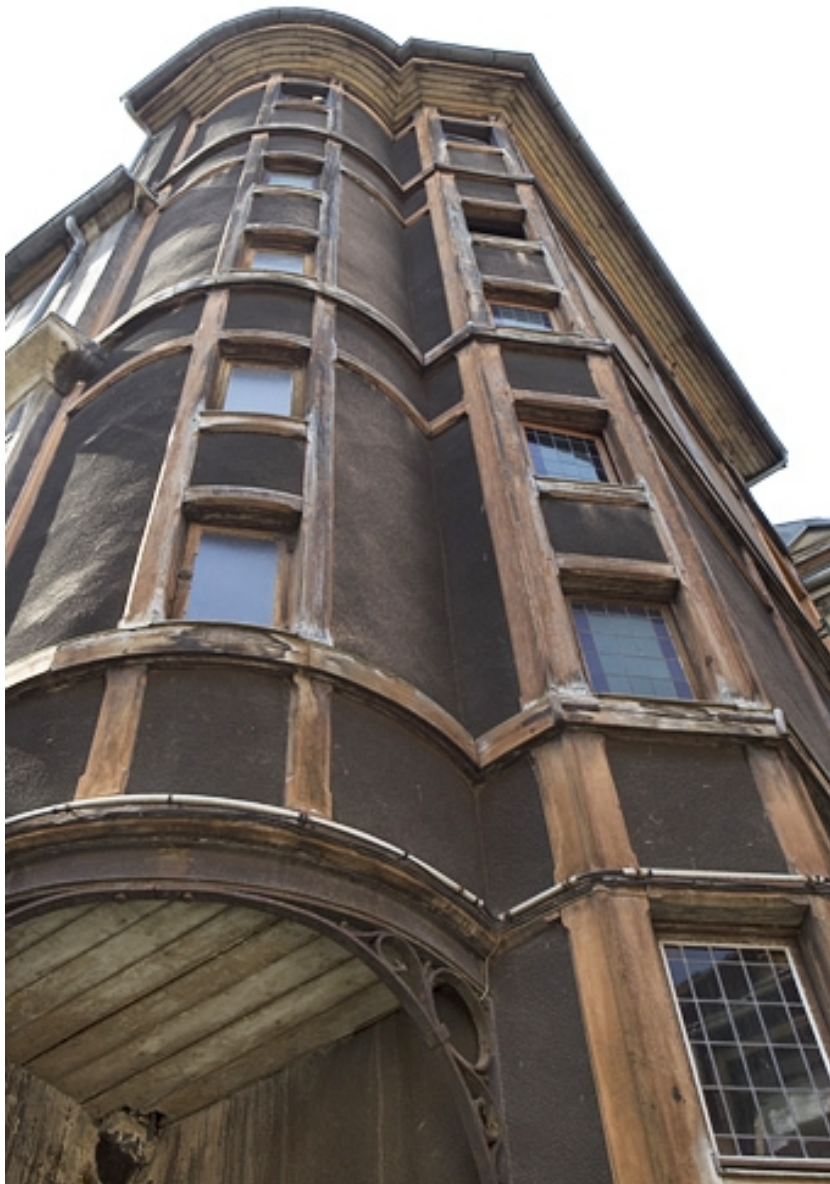
Vue d'ensemble de la cage d'escalier en pan de bois.
