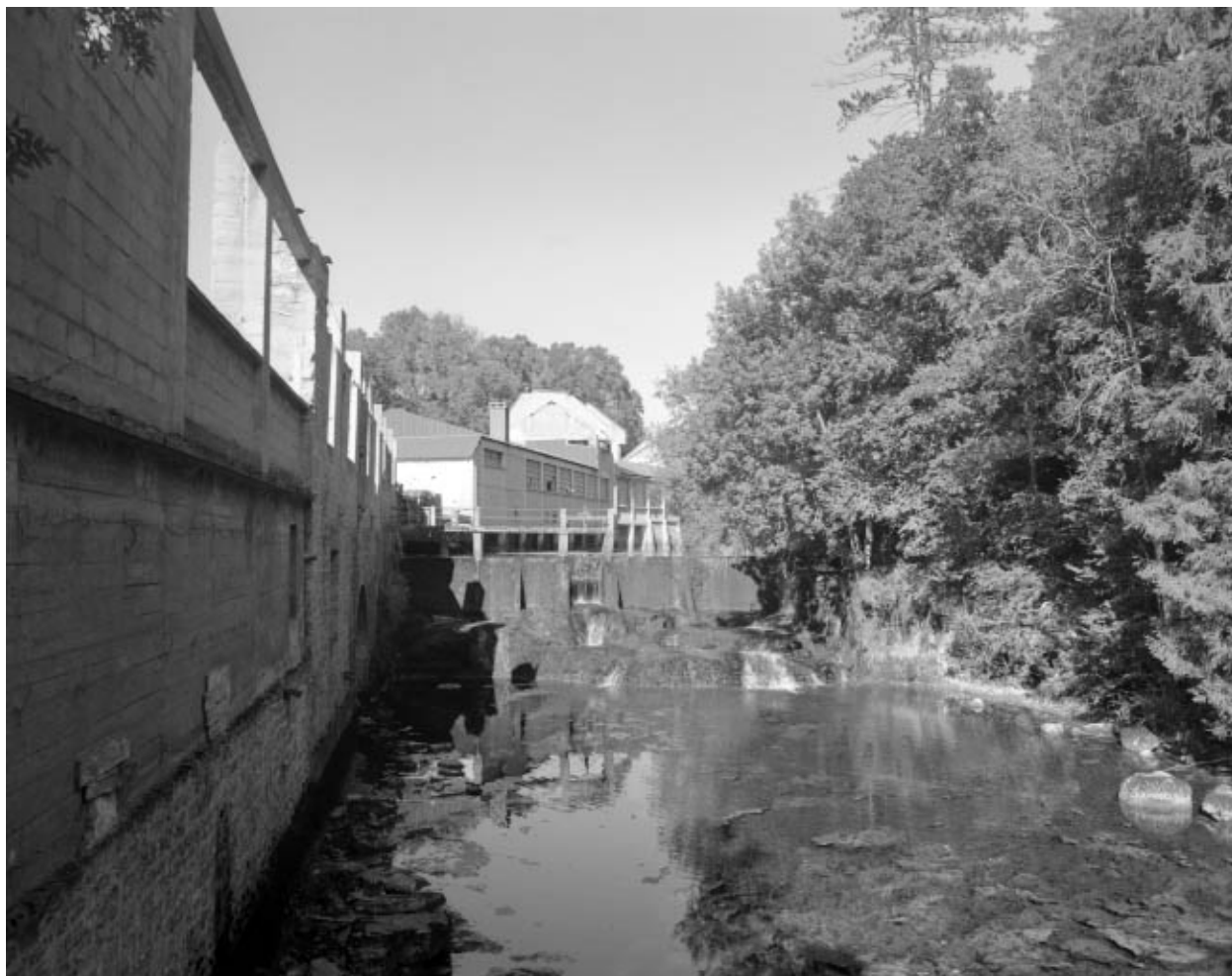
Façades de l'usine sur l'Angillon et barrage.
