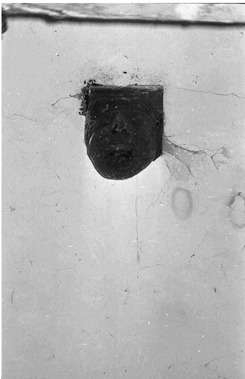
Choeur, extrémité sculptée d'un poinçon pendant de la charpente.
