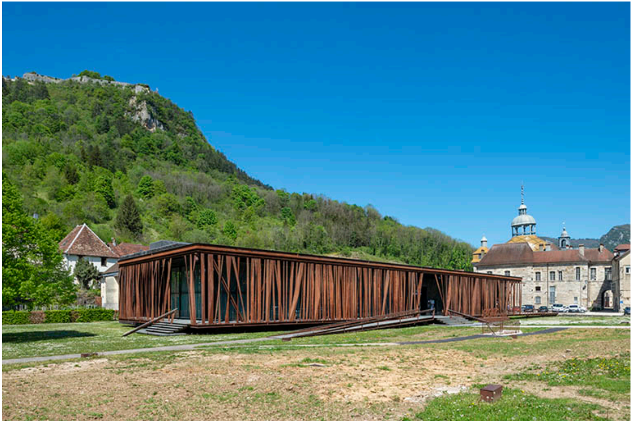
Vue d'ensemble de l'édifice surplombé par le fort Saint-André.
