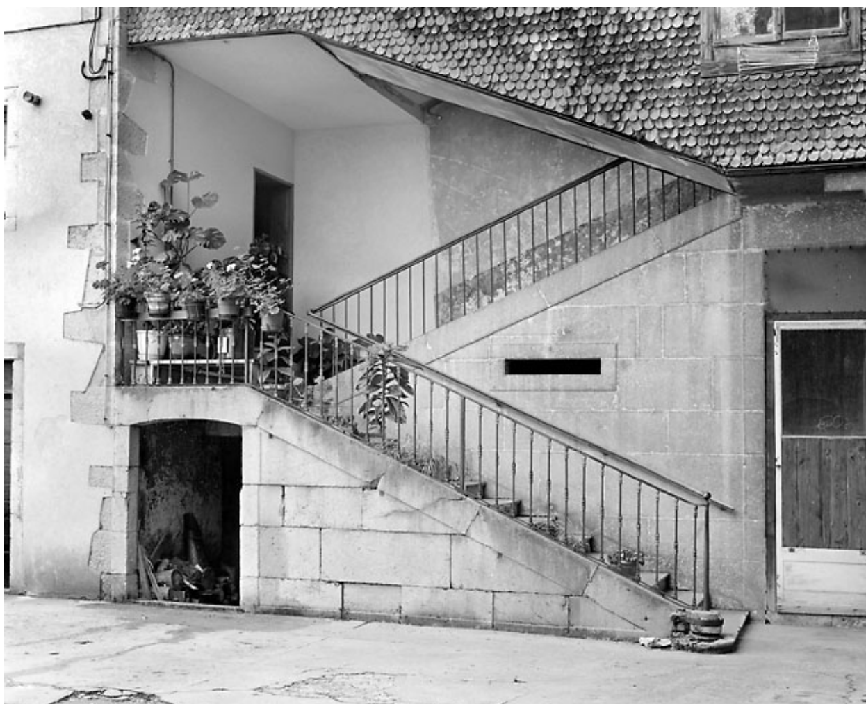
Escalier sud : cage ouverte au rez-de-chaussée.
