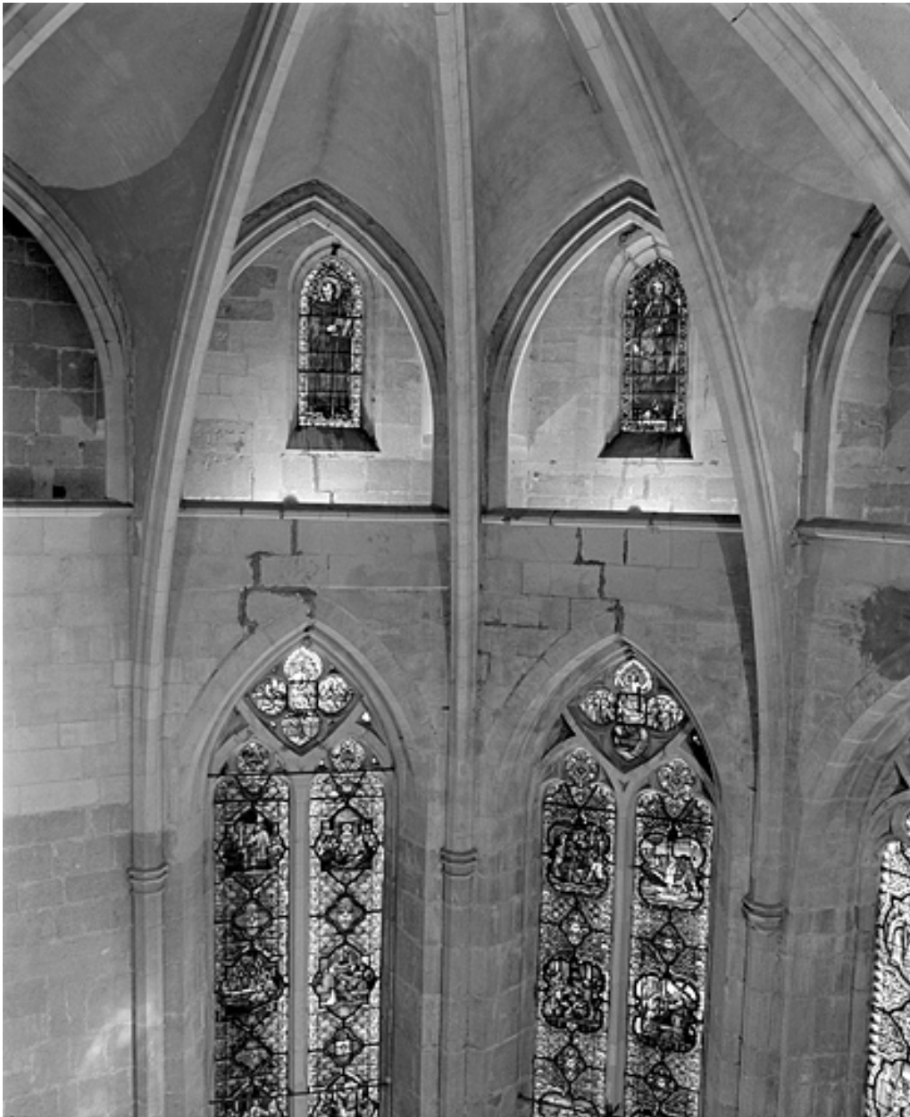
Baies de l'abside depuis la coursière haute.
