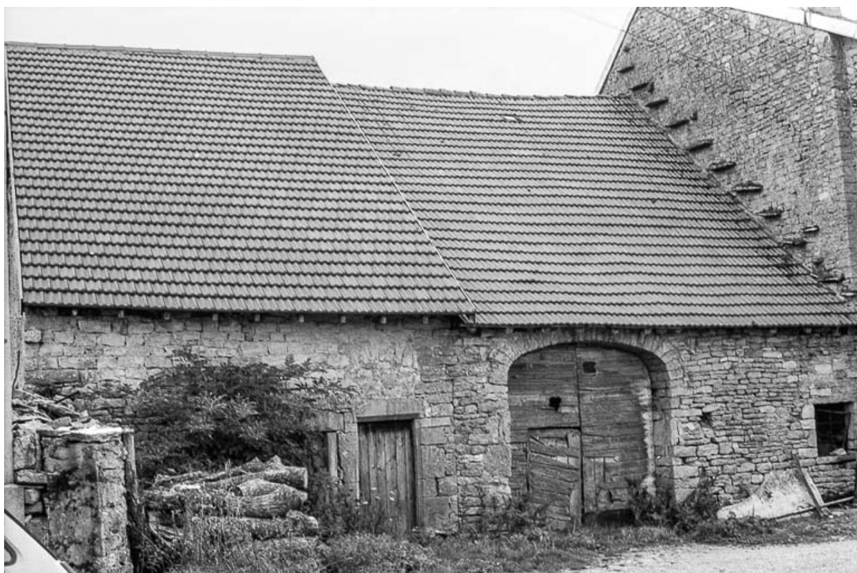
Ferme cadastrée B2 176 : façade postérieure.
