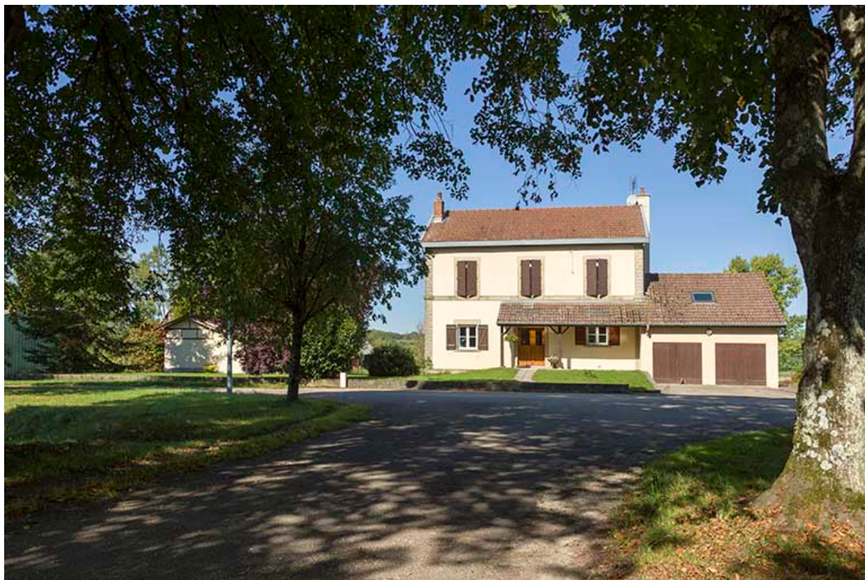
Façade sud-est de l'ancienne gare.
