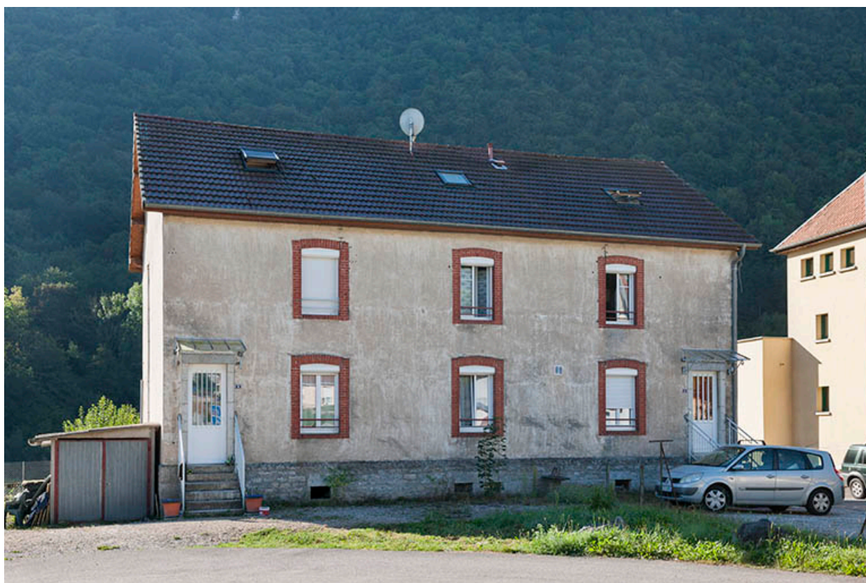
Logement ouvrier (sud) à 4 appartements. Façade ouest.
