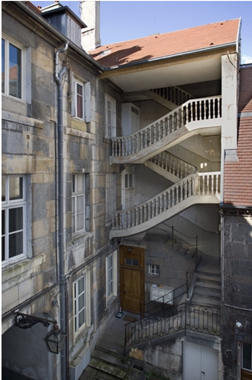
Vue d'ensemble de l'escalier à droite de la cour.
