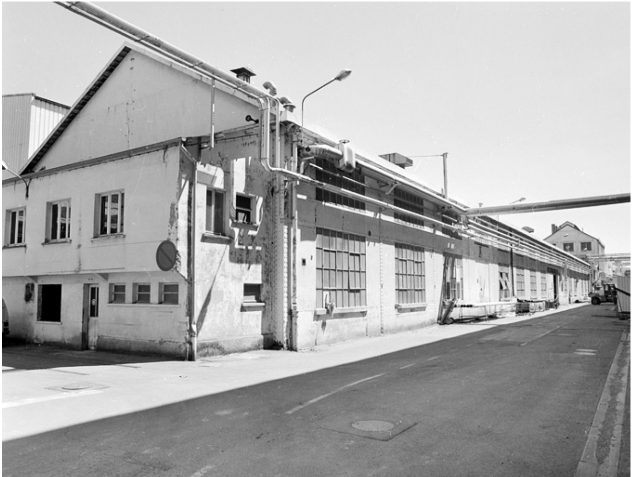
Ancien atelier de petite chaudronnerie.
