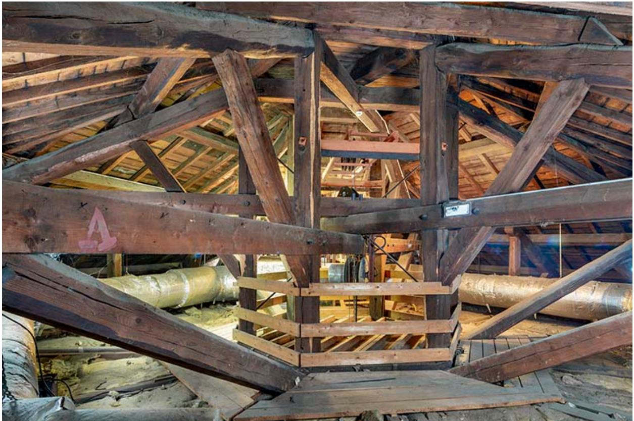
Grand Kursaal, comble : partie centrale de la charpente.
