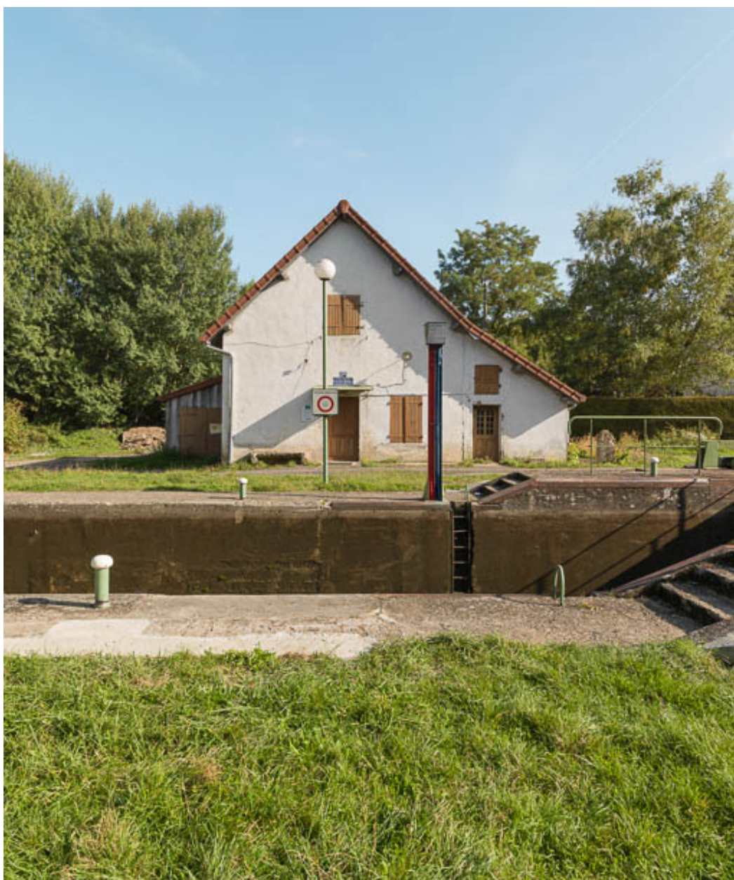
Vue de la maison éclésièr.
