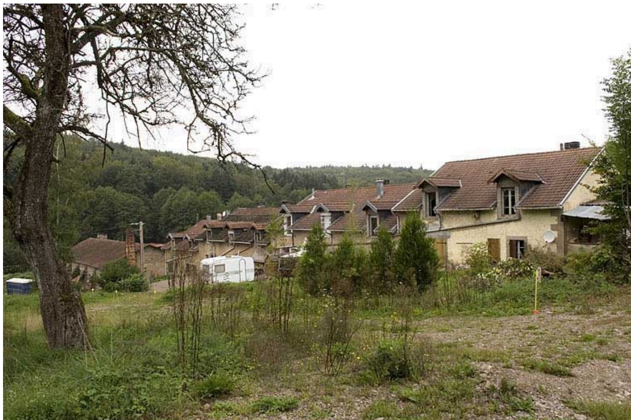
Halle et logements d'ouvriers depuis le sud-est.
